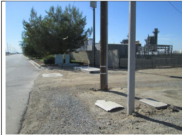
Idaho Avenue frontage
