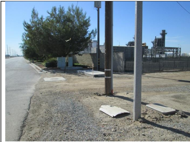
Idaho Avenue frontage
